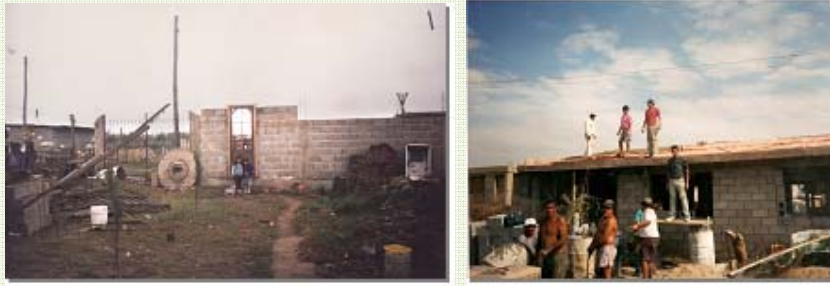
Casas de Lili y Miguel. En proceso de construcción. Año 1996.
