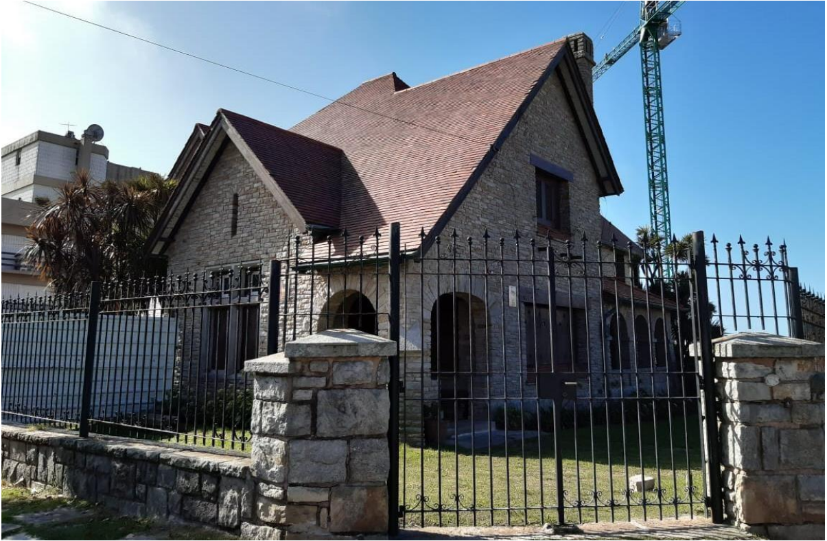
Figura 3. Imagen aérea del Chalet de Mores, ubicado en la ciudad de Mar del Plata. Fuente: fotografía propia.
